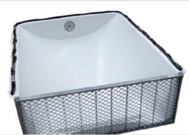
Einbringen des Dichtmittels ACO Dichtfix in die Kittrille des Lichtschachts
