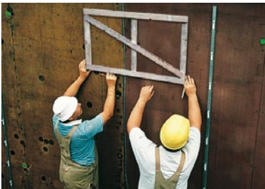
Stützkreuz auf richtiger Höhe waagrecht fixieren
