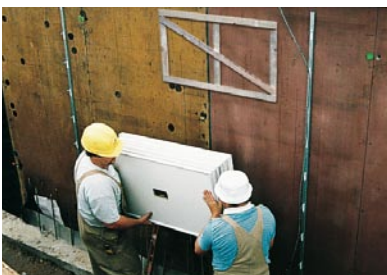
ACO Therm Leibungsfenster auf das befestigte Stützkreuz stecken und mit den an den Leibungsfenstern angebrachten Lochstreifen sichern
