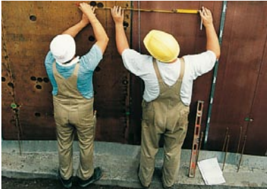
Position Leibungsfenster/Stützkreuz einmessen
