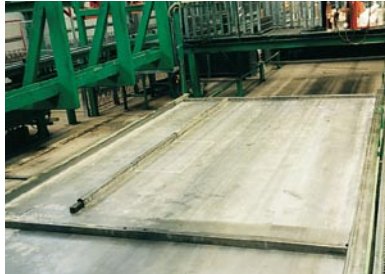
Aufplotten bzw. Einmessen der Fensterposition auf dem Schaltisch
