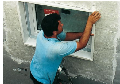
Zusammengesetztes Dämmungsanschlussprofil nach Abschluss der Wandbelagsarbeiten in die durch das Entfernen der Schalungsabdichtung entstandene Nut einsetzen
