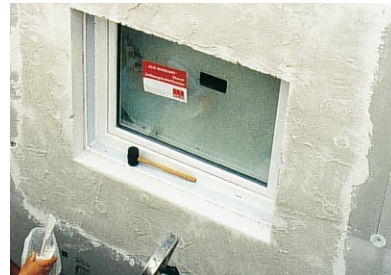
Das Dämmungsanschlussprofil ist leicht auf die vor Ort benötigten Dämmungsstärken von 100/80/60 cm oder 110-200 mm ohne Werkzeug anpassbar
