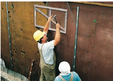
Stützkreuz auf der Schalung befestigen
