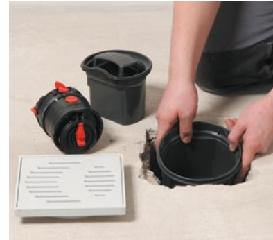
Installation des neuen ACO Junior mit Verbindung zur Entwässerungsleitung.
