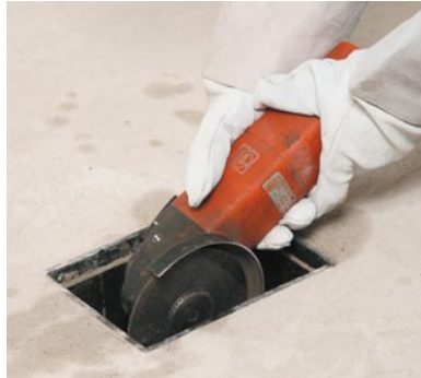
Ausstemmen des alten Kellerablaufs.
